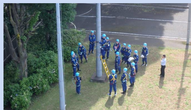
模擬無線鉄塔上での高所作業実習
