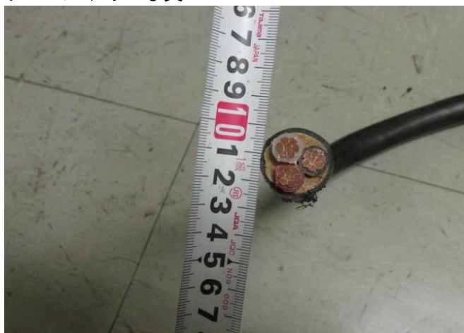
ケーブルサイズ写真
